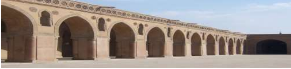
(شكل رقم 2) نموذج أحمد ابن طولون حيث وظفت الفتحات لتخفيف الأحمال على الأعمدة الحاملة للعقود (2)
